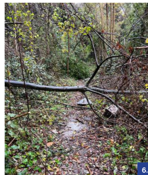
6. Presenza di rami che intralciano il passaggio lungo il tracciato. EL_1
