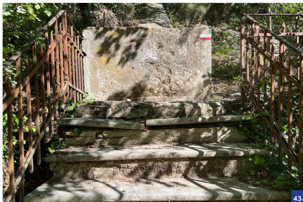
42. Scala con gradini in lastre di calcare marnoso e struttura in pietra. EL_G3 43. Scala in pietra con pedate realizzate in lastre di arenaria con i bordi arrotondati. EL_35
