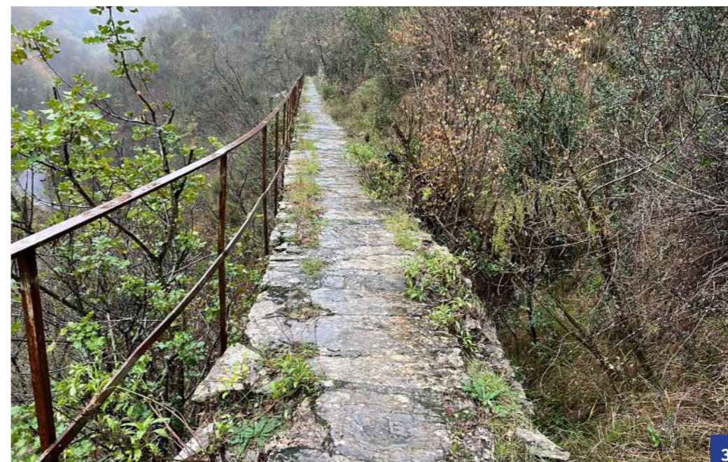
3. Tratto del condotto con pavimentazione in blocchi di calcare marnoso di forma irregolare e grande spessore con le teste dei muri visibili. Presenza di un parapetto metallico sul lato a valle. EL_P1
