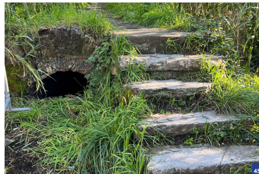
44. Scala del ponte sifone del Veilino; i gradini sono realizzati in lastre di arenaria. EL_75 45. Scala in pietra di raccordo tra la quota dell'estradosso della galleria e quella del tracciato ordinario, in località Ruinà. EL_G3
